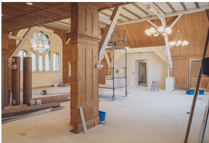
Die ehemalige Kapelle dient neu als Seminarraum.
