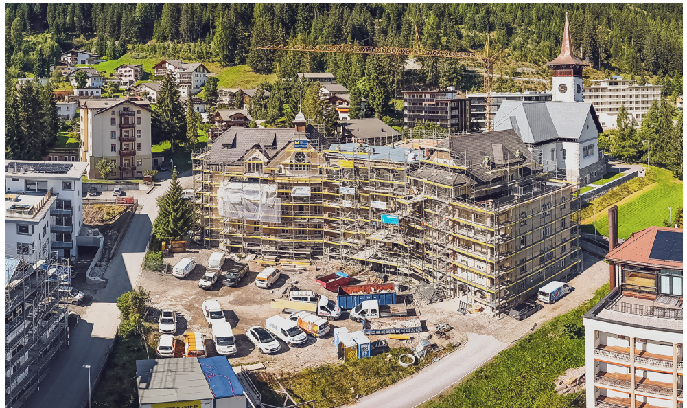
Über die letzten Monate wurde das Joseph's House totalsaniert.
