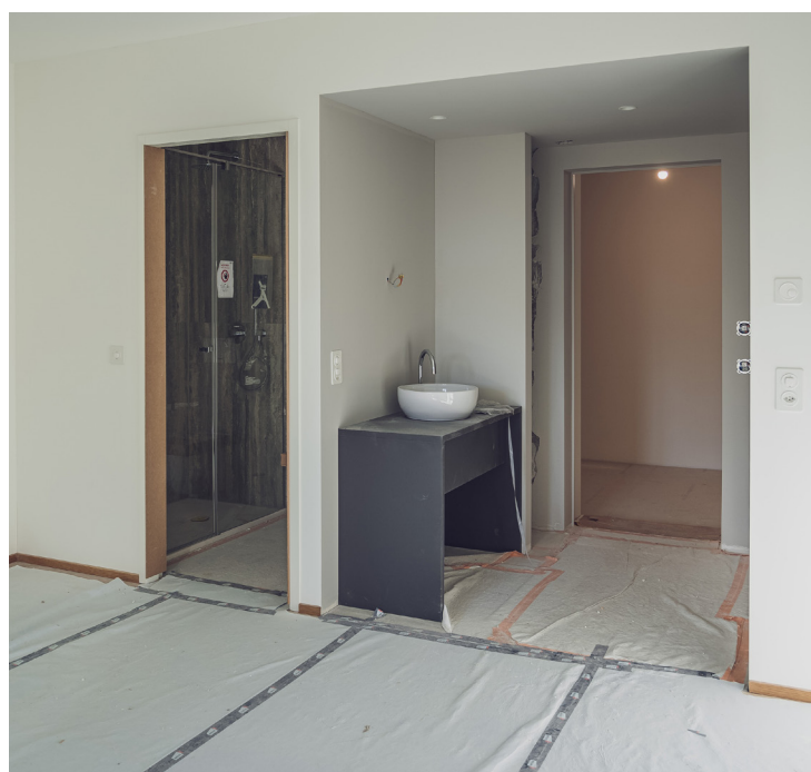
Jedes der rund 70 neuen Zimmer hat eine eigene Nasszelle.
