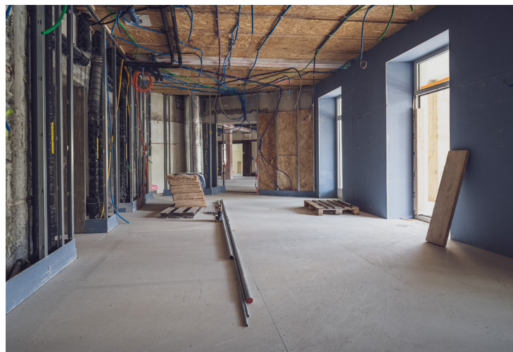
Im baufälligen Gebäude wurden Kilometer an neuen Leitungen verlegt.
